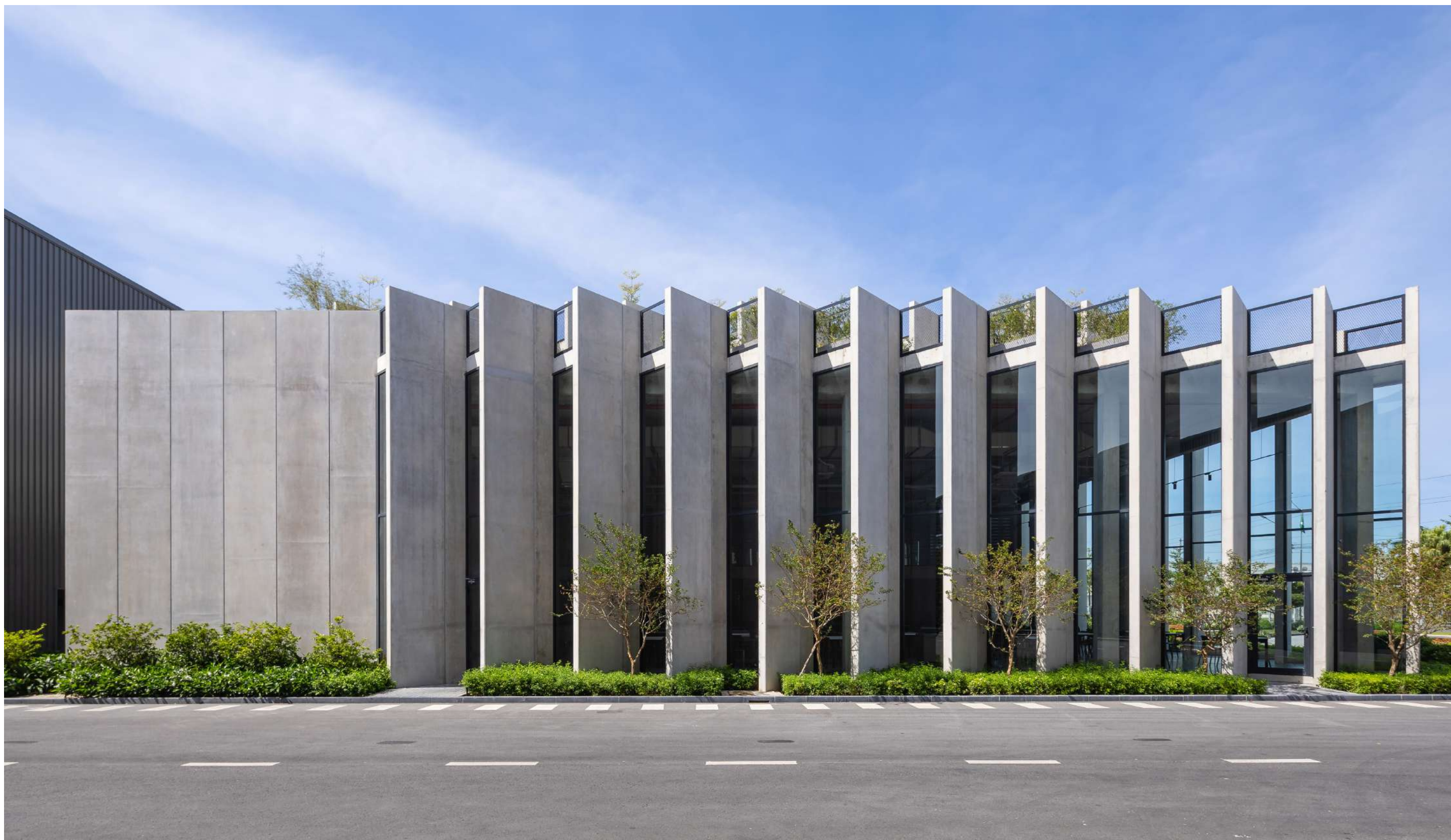
Các hệ lam bê tông và nhôm kính được bố trí theo góc xoay hợp lí với vi khí hậu, tận dụng tối đa khả năng che chắn nắng của vách tường nhưng vẫn đảm bảo đủ ánh sáng và thông gió tự nhiên đem đến một không gian sinh hoạt và làm việc tiện nghi, thoải mái, ấm về đông, mát về hè cho cán bộ nhân viên..
