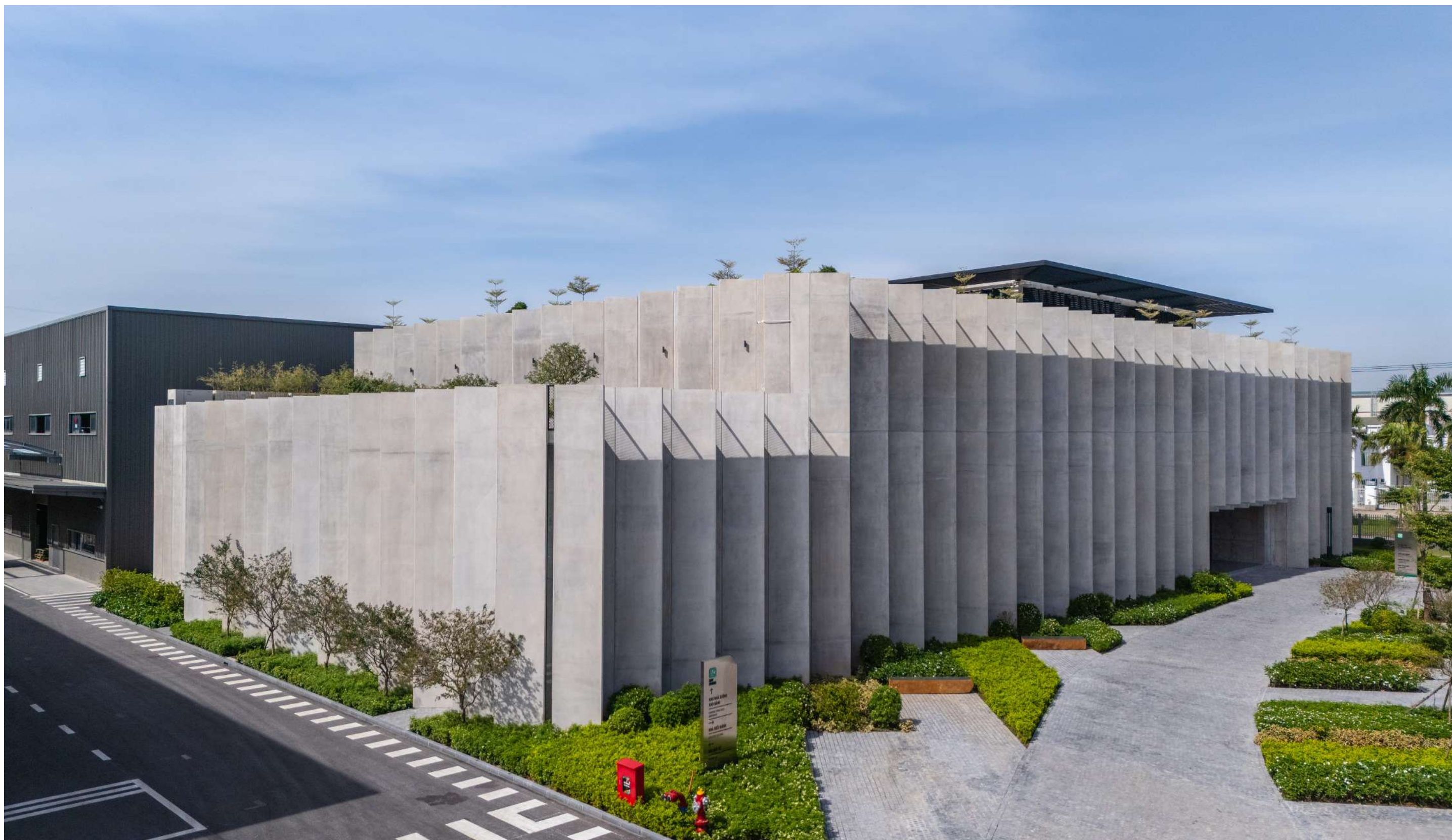
Vỏ ngoài của toà nhà được xác định là sự kết hợp của các yếu tố xây dựng như tấm pin và cửa sổ có tính đến tỉ lệ năng lượng mặt trời cụ thể, giảm nhiệt độ của toà nhà, và do đó giảm mức tiêu thụ năng lượng được sử dụng để cho mục đích làm mát và điều hoà của không gian nội thất có người sử dụng.
