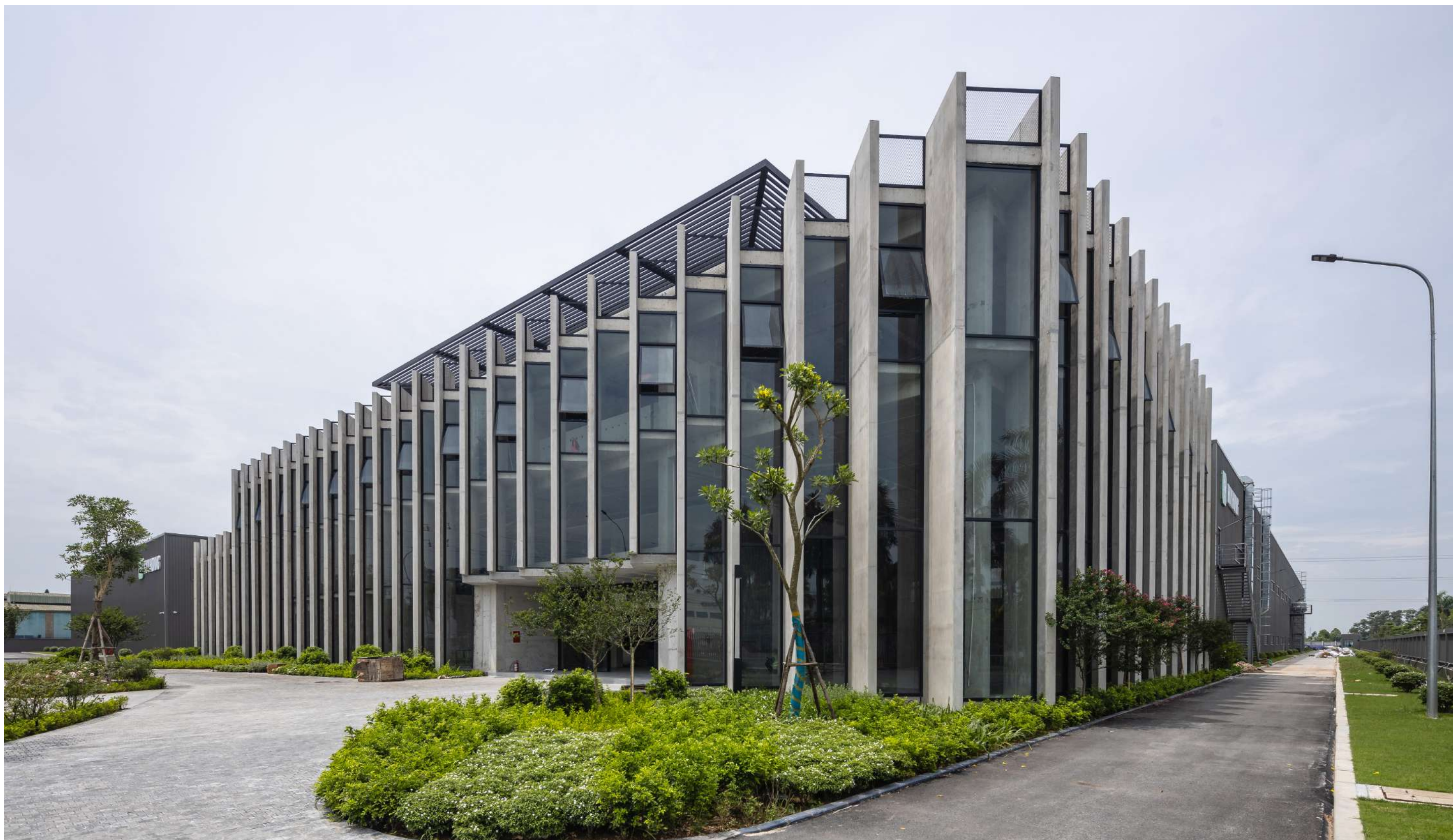
Công trình ấn tượng với lối kiến trúc mở nhưng rất hài hòa với tổng thể của toàn bộ nhà máy.
