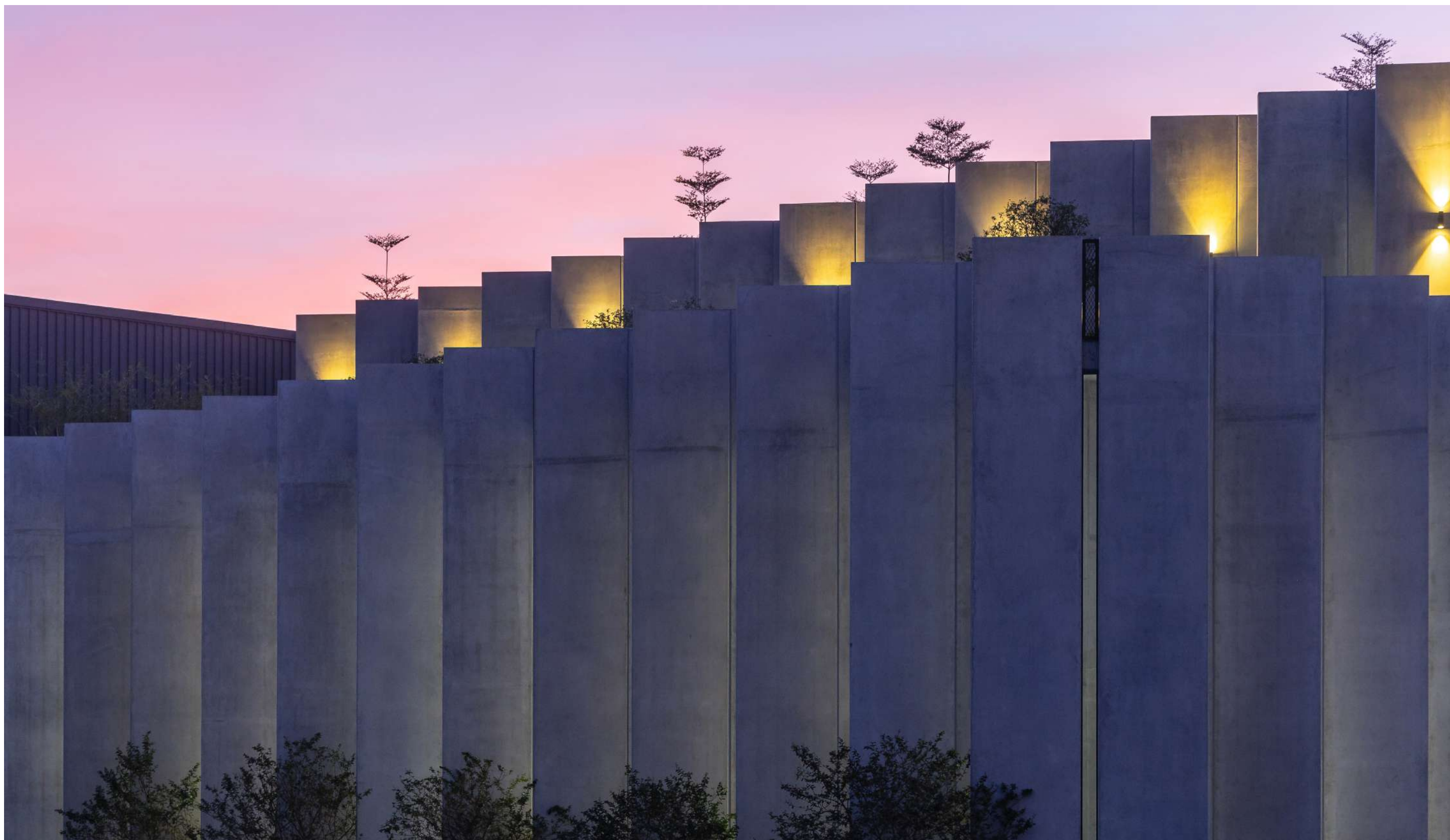
Thiết kế ánh sáng của công trình được thể hiện rõ nét nhất khi công trình trong thời điểm mặt trời lặn.
