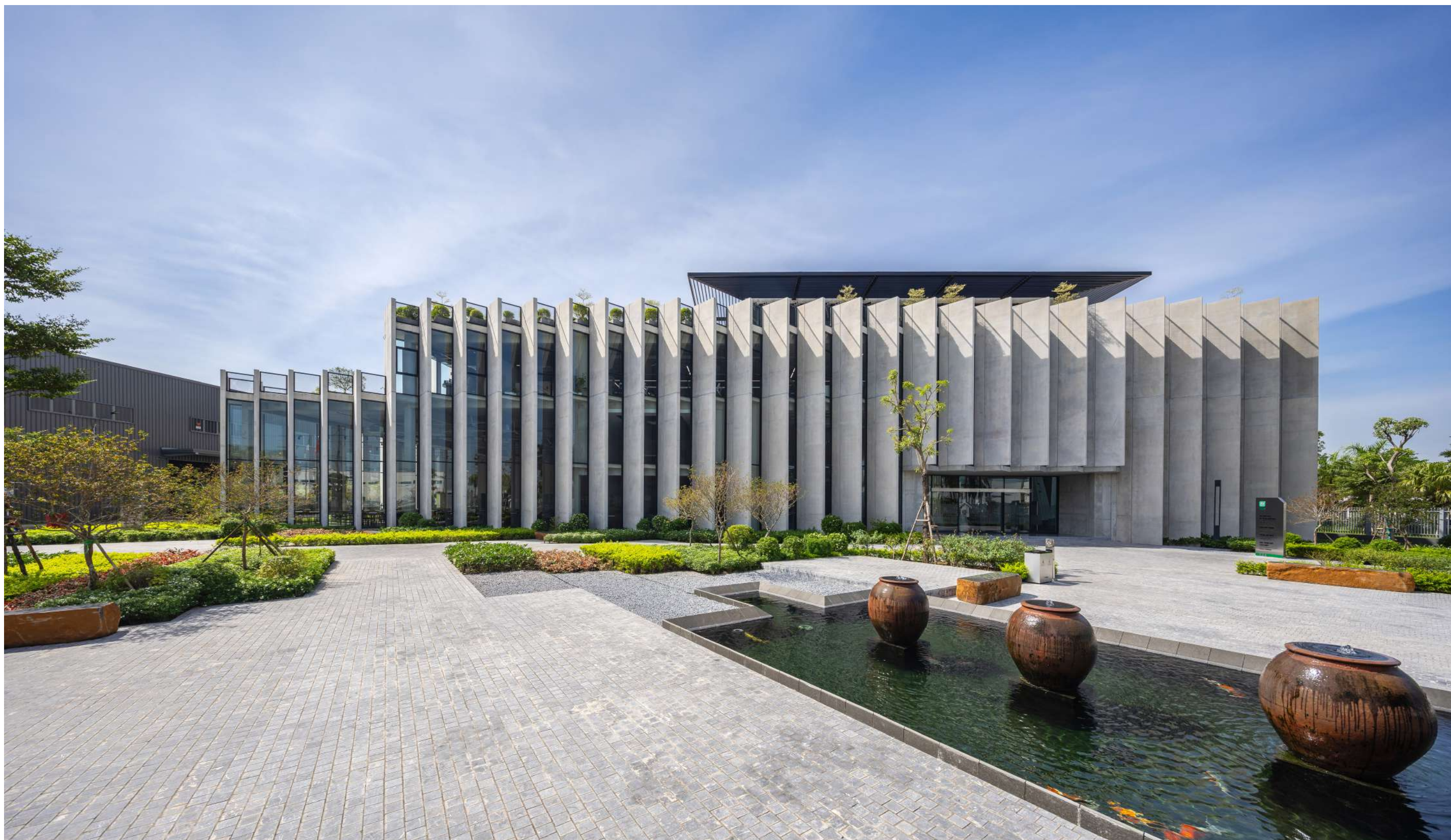
Mặt đứng văn phòng là sự đan xen của những hệ lam bê tông và vách nhôm kính bằng cao hình thành sự tương phản đặc rõng tạo ra sự độc đáo cho công trình ở những góc nhìn khác nhau.
