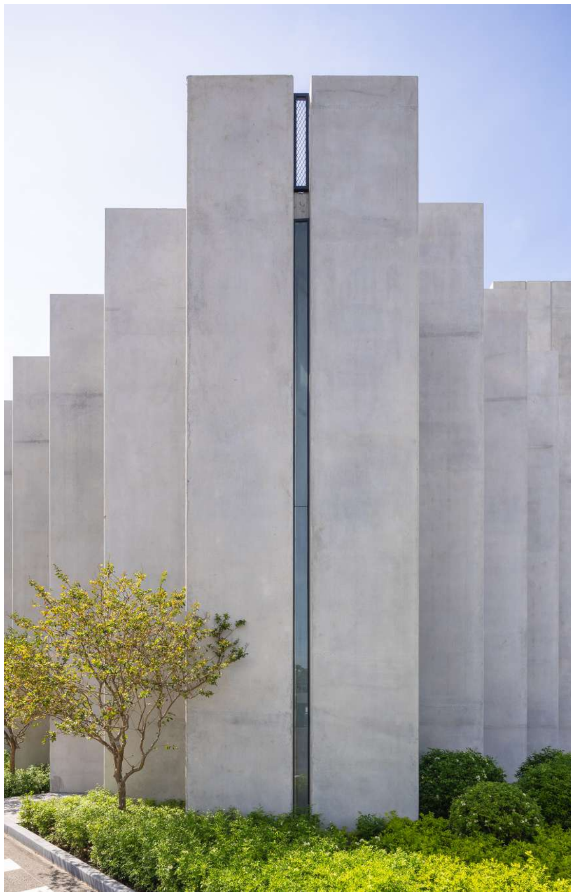
Hình ảnh các đường zigzag đưa vào thiết kế của lớp vỏ công trình được thi công bằng vật liệu bê tông trần.
